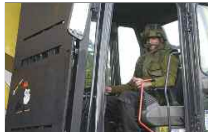
Oppdrag for Forsvaret krever spesialutstyr. Denne gravemaskinen er forsynt med panserstål foran frontglasset, og føreren ser ved hjelp av et kamera og skjerm inne i maskinen. – Vi har bestilt en fjernstyrt maskin slik at man kan stå på trygg avstand og kjøre den, sa Pedersen.
