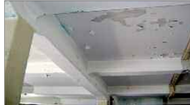
Takmalingen i dette nedlagte fiskebruket inneholdt 21 000 mg/kg (altså 2,1 prosent) PCB.
