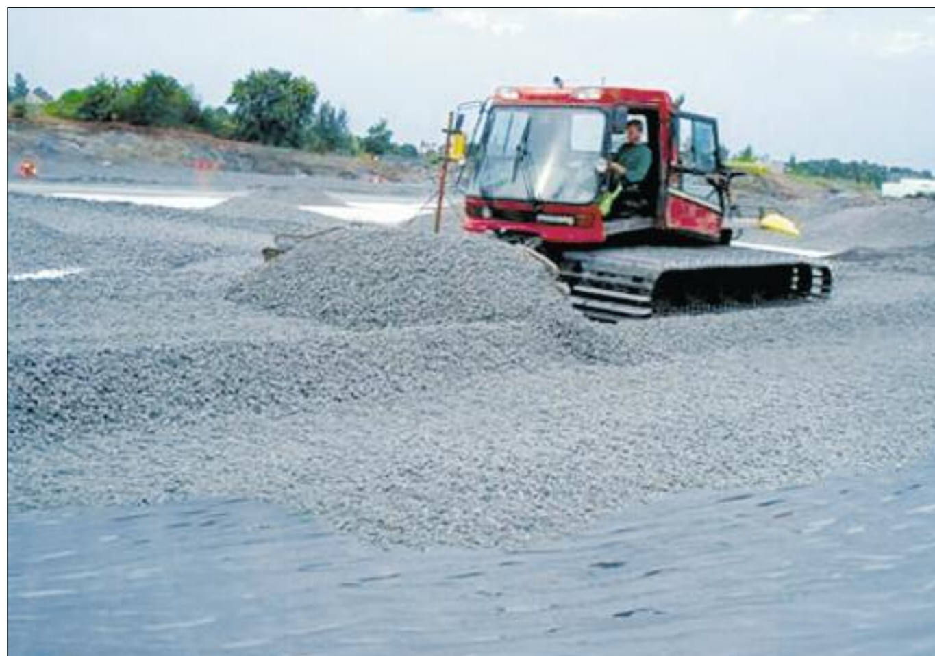
Fra utleggingen av skumglass ved byggingen av kunstgressbane på Fornebu Park. Totalt 1800 m 3 skumglass ble brukt her. www.glasopor.no
