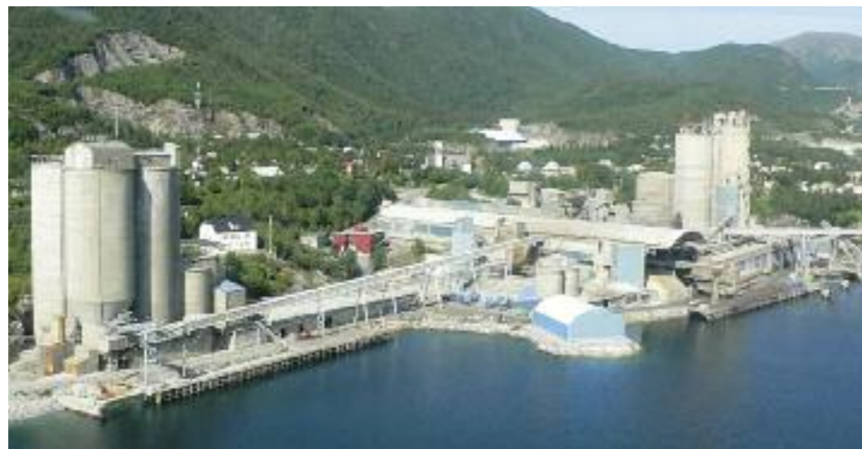
Sementfabrikken i Kjøpsvik har investert i et doseringsanlegg for avfall til sementovnen, og vil bli en stor aktør i det nordnorske avfallsmarkedet framover. I første omgang er det inngått avtale med Veolia om mottak av 20 000 tonn forbehandlet restavfall.
