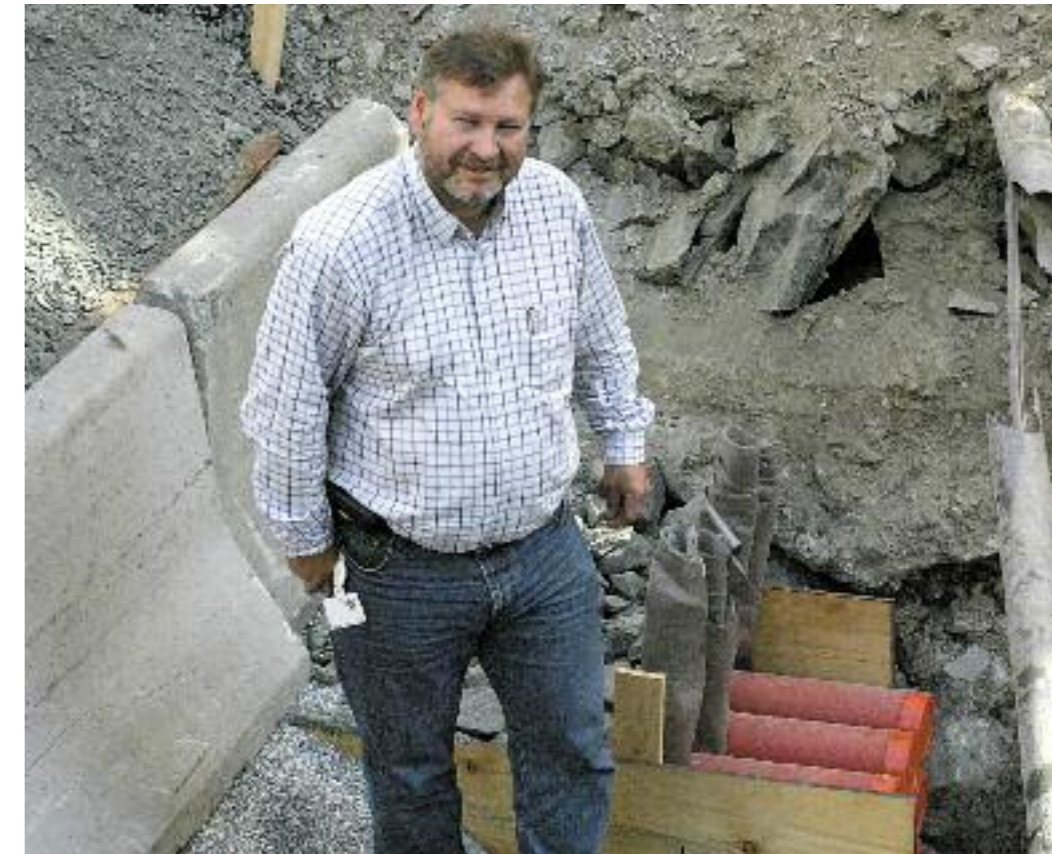
Ove-Henning Bjørsvik mener tilknytningsplikt til ny avfallsinfrastruktur er like naturlig som den er det er for vann og kloakk. Her i full gang med bossnettet i Bergen.
