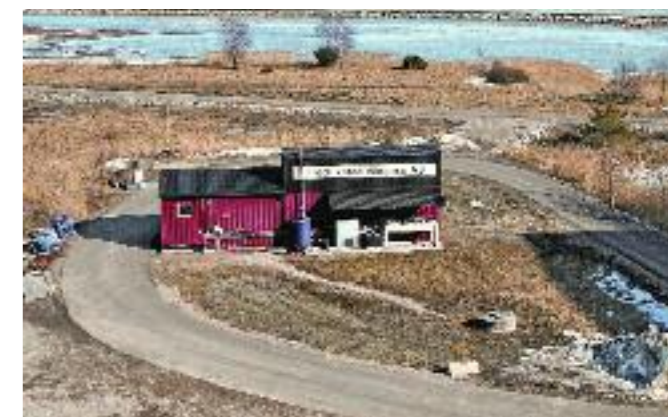
Fredrikstad Biogass består av et oppgraderingsanlegg som ligger unnselig i utkanten av FREVARs område mot sjøen. Det lille huset er nok til å romme anlegget med metankompressor og et lite kontrollkontor. Bak står to tanker med ferdig metangass. Anlegget trenger ikke mye tilsyn, men driftes av FREVARs personale.
