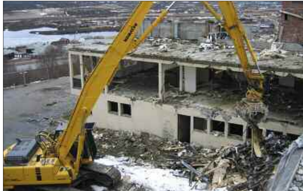
Dersom den nye plan- og bygningsloven ikke blir endret i høringsrunden, vil kravet om avfallsplan og miljøsaneringsbeskrivelse, som ble innført over hele landet fra 01.01.2008, bli fjernet igjen. Her fra rivningen av Kautokeino Hotell.
