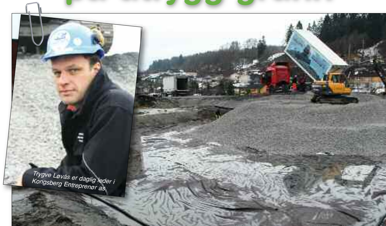
Kvikkleire erstattes med Glaspopor i Kobbervikdalen
