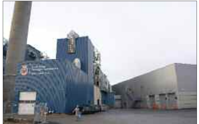
Den nye sorteringshallen er det grå bygget til høyre, som altså er bygd sammen med forbrenningsanlegget.
